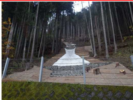
災害復旧後の治山施設
