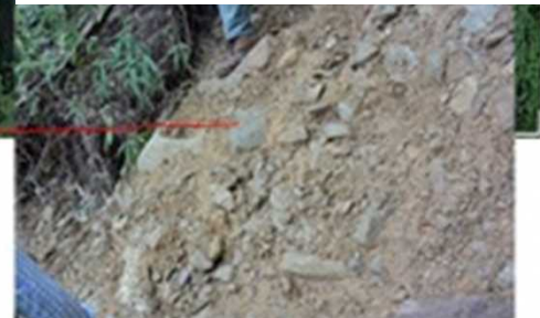
崩壊面向かって右側の粘性土 水を含んでいる
