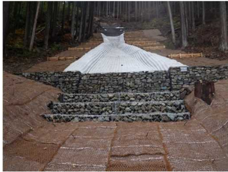
復旧後の治山施設
