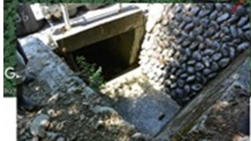
道路暗渠 (土石流により閉塞)
