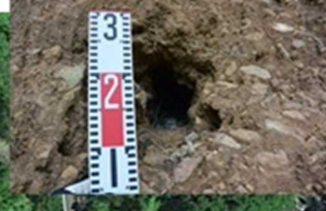
崩壊頂部に見られた孔
