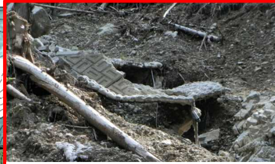
コンクリート片 (H29治山工事)
