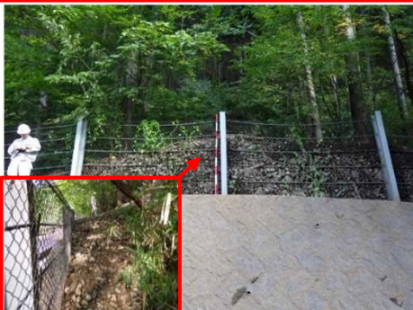
土砂は落石防護柵で捕捉
