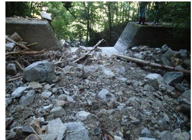
地点A-1：治山堰堤の上流 (概ね岩盤が露出)
