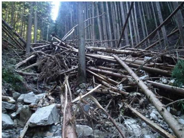
地点A-2：立木で捕えられた河床部の流木だまり
