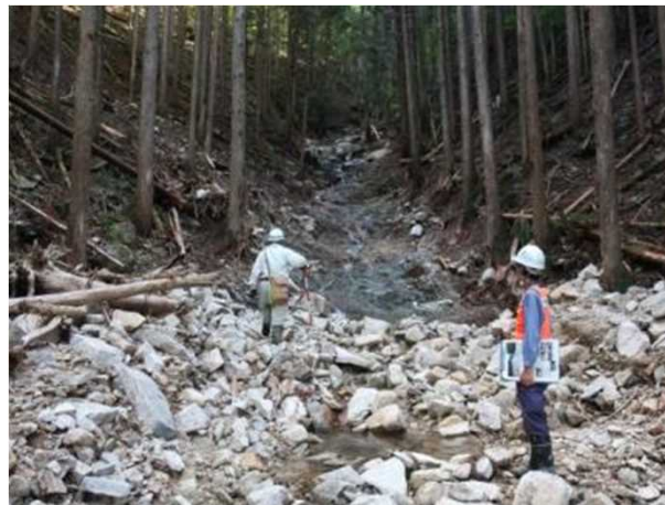
地点A-3：流木だまりの上方(岩盤が露出)
