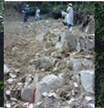
崩壊面向かって右側の岩石
