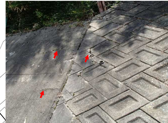
コンクリート擁壁東側、ブロック積擁壁との境界付近に確認される亀裂
