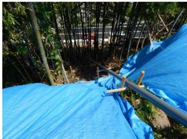
写真5 頭部滑落崖状況
