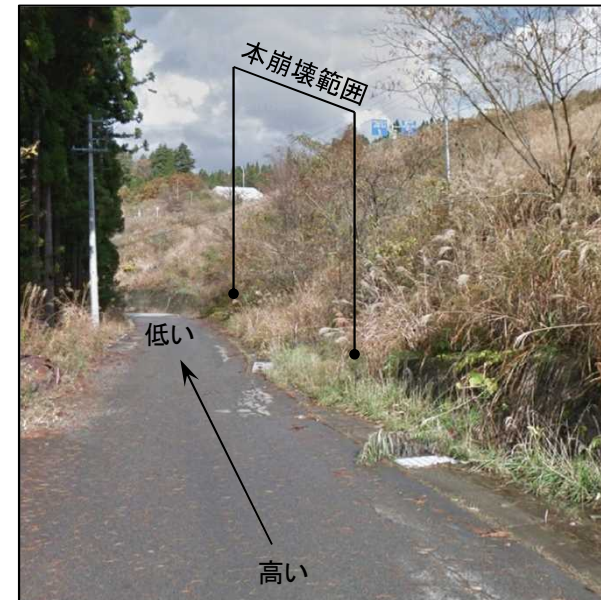
写真-8 崩壊前ののり尻状況
