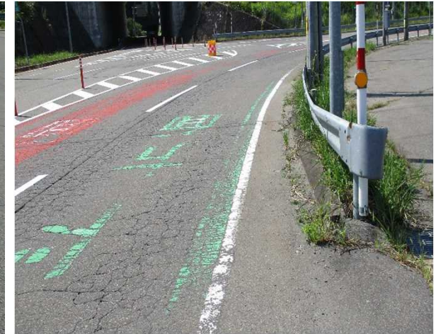
写真-7 崩壊箇所直上のアスファルト面に見られる亀裂
