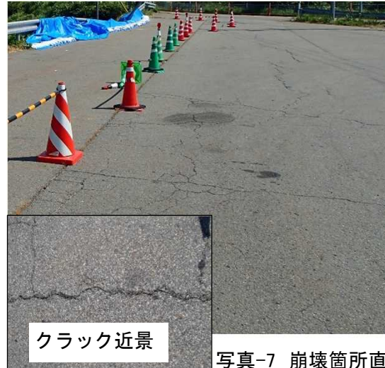
写真-7 崩壊箇所直上のアスファルト面に見られる亀裂
