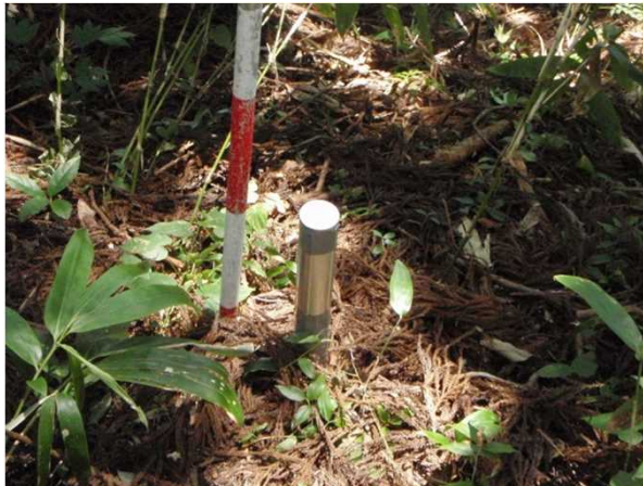
上方斜面内に認められた孔内傾斜計観測孔
