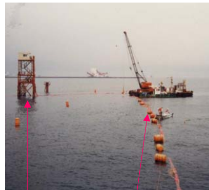
発泡スチロールを付けたケーブル
