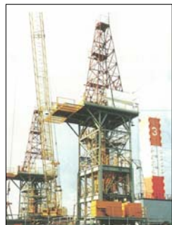
(SEP上のボーリング架台)
