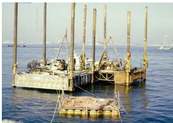
(計器埋設状況: 満潮時)
