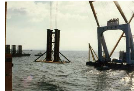
CB沈下板 (4本) 敷設状況
