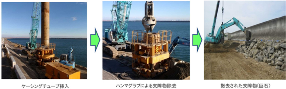
図 3.2.62 地中支障物(巨石)の撤去状況 20)
