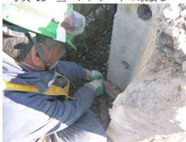
写真 17 ベルト状補強材の切断
