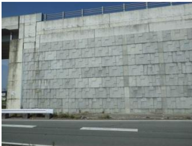
写真 1 直壁タイプ（コンクリートパネル）
