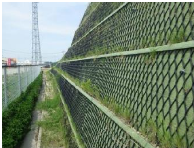
写真 2 斜壁タイプ（鋼製枠）
