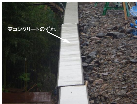
写真 14 笠コンのずれ
