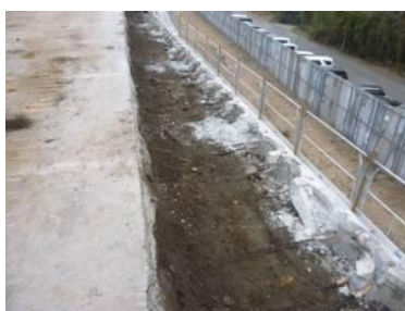
写真 16 笠コンクリートの取壊し
