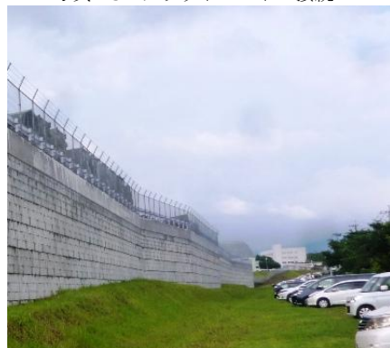
写真 20 復旧工事完了後
