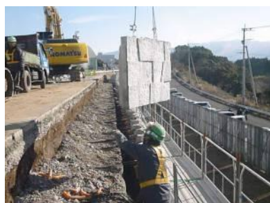
写真 18 破損したコンクリートパネルの撤去
