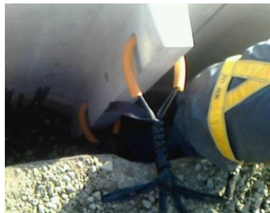
写真 19 グリッドベルトの接続
