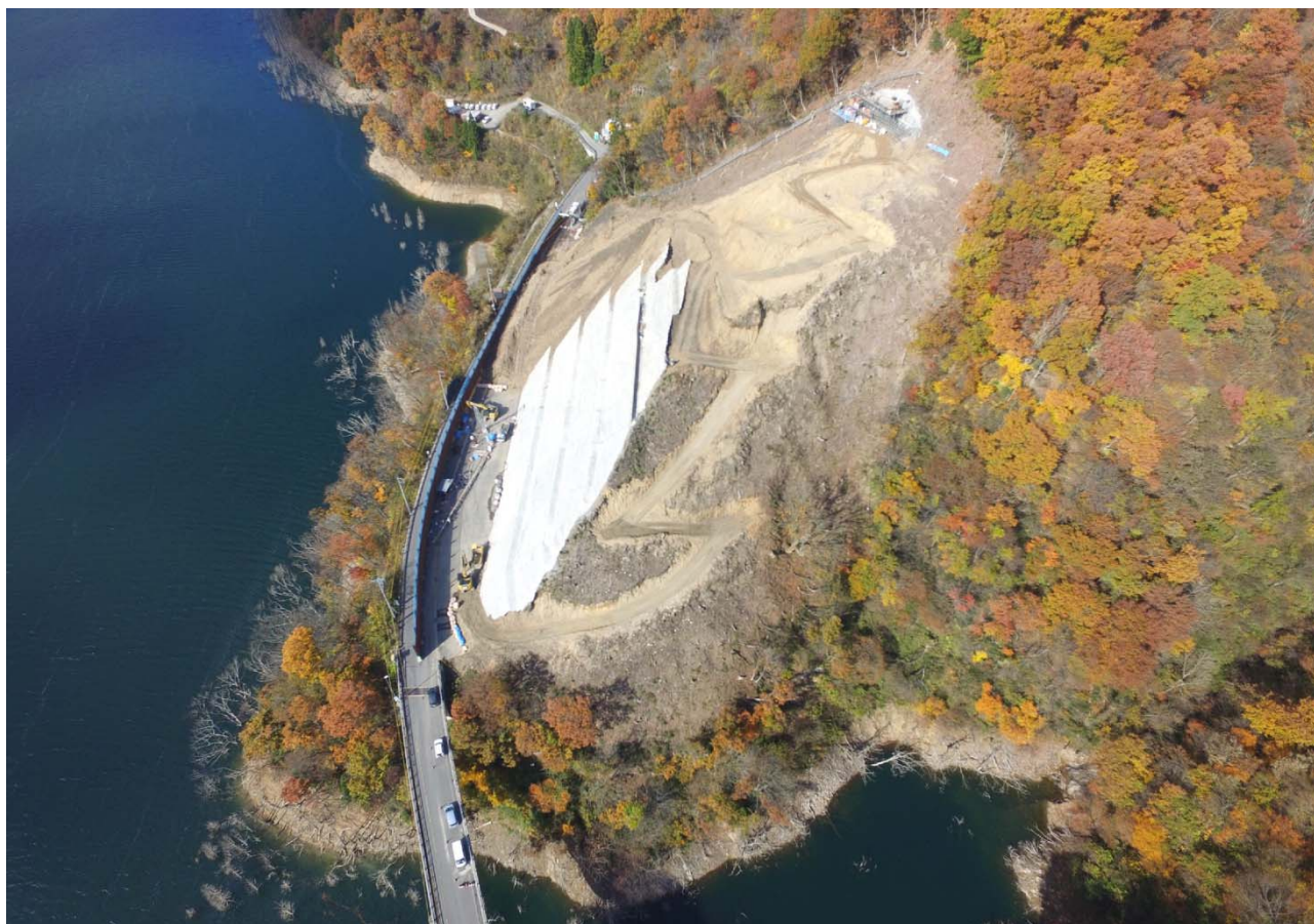
写真-5 現在の施工状況
