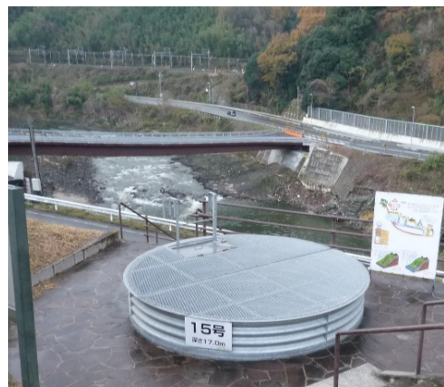
写真-4 柏原市の地滑り区域にある 集水井と亀の瀬（右が下流）
