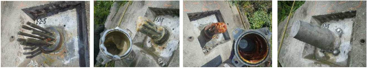
防錆油除去後頭部状況 頭部キャップ防錆油充填 頭部キャップ取外し防錆油状況 調査完了
