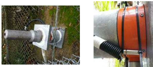
写真-5 向山TN北坑口における荷重計設置状況
