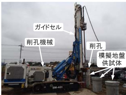
写真-3 模擬地盤での削孔試験状況
