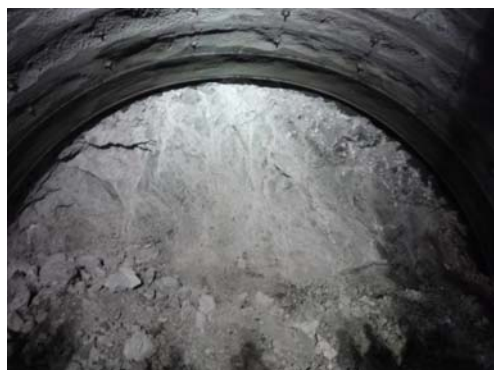
写真-4 花崗閃緑岩の熱水変質帯
