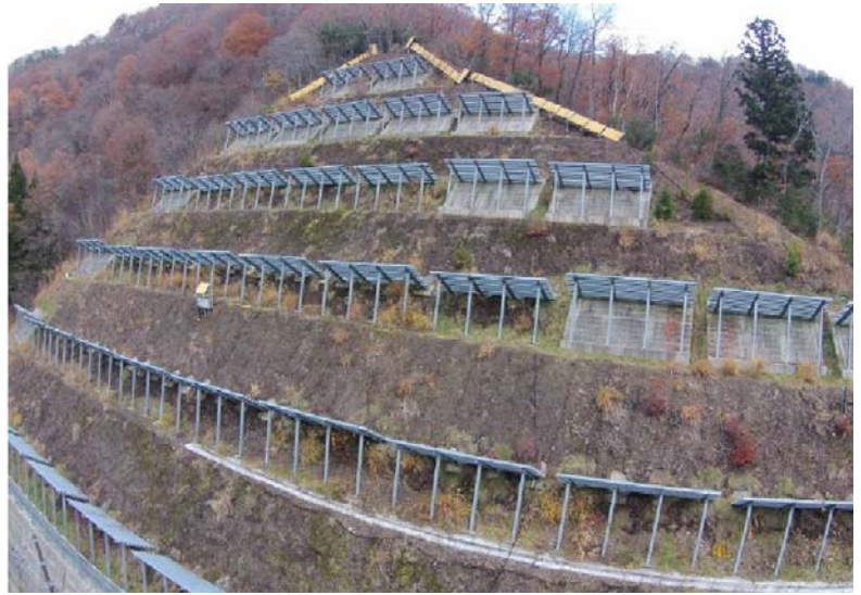
写真-4 現況雪崩予防柵設置状況
