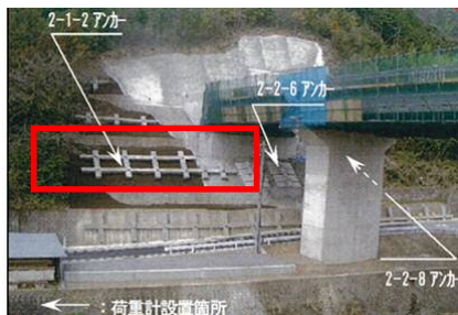
写真-3 加治田高架橋下の状況
