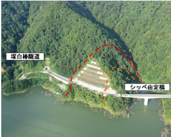
写真-1 地すべり箇所空中写真
