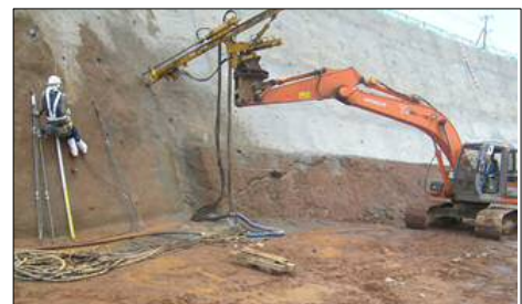
図-4 ロックボルト施工状況
