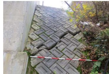
写真-3 橋台取付擁壁クラック
