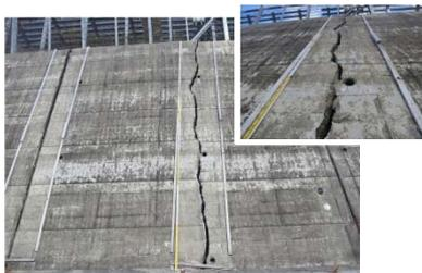
写真-1 切土末端擁壁クラック
